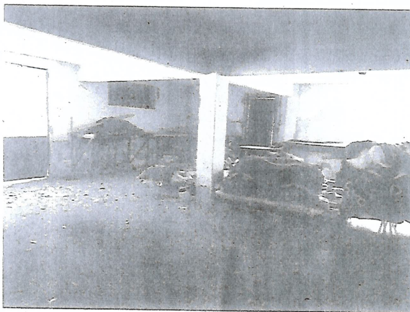
Vista parcial da garagem.
